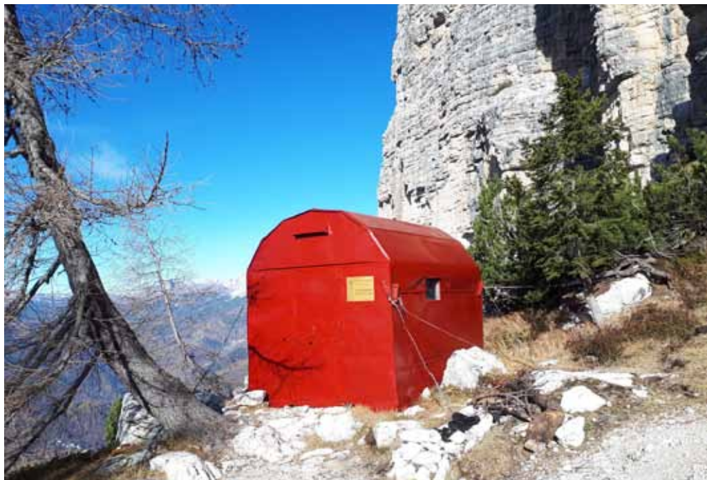
Il Bivacco Carnielli-De Marchi dopo la manutenzione.
